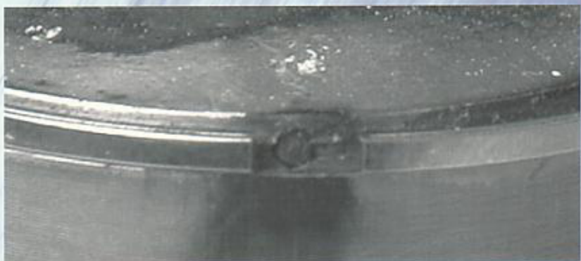
Fig 3/15 FUITE DE GAZ EXCESSIVE
